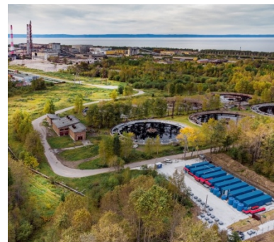
ОАО «БЦБК». ЦЕХ ОЧИСТНЫХ СООРУЖЕНИЙ
