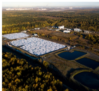
ПОЛИГОН ТОКСИЧНЫХ ОТХОДОВ «КРАСНЫЙ БОР»
