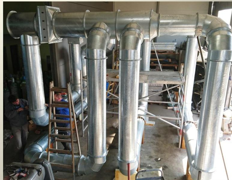
Трубопровод с системой байпаса
